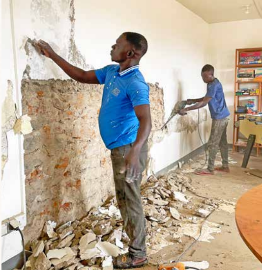
Wasserschaden an der Wand in einem der Stationshäuser
